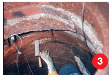
3. Отверстие очищается от сыпучего строительного раствора, затем заполняется Энекрит ВП для мгновенной остановки утечки и формирования водонепроницаемой пробки...
