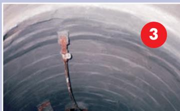
3. В результате – защищенная, уплотненная и гидроизолированная с помощью Энекрит ВС поверхность всего за несколько простых шагов.
