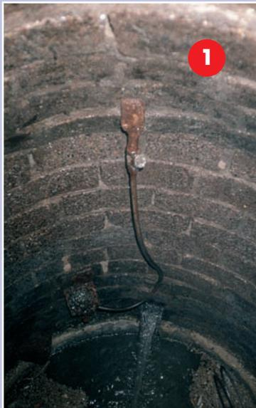
1. Проблема – стены подвергаются химическому воздействию при активных утечках воды...
