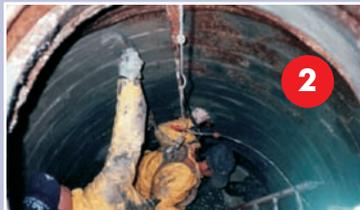
2. После закупорки активных утечек с помощью Энекрит ВП на стены кистью наносится два слоя Энекрит ВС – гидравлического уплотнителя.
